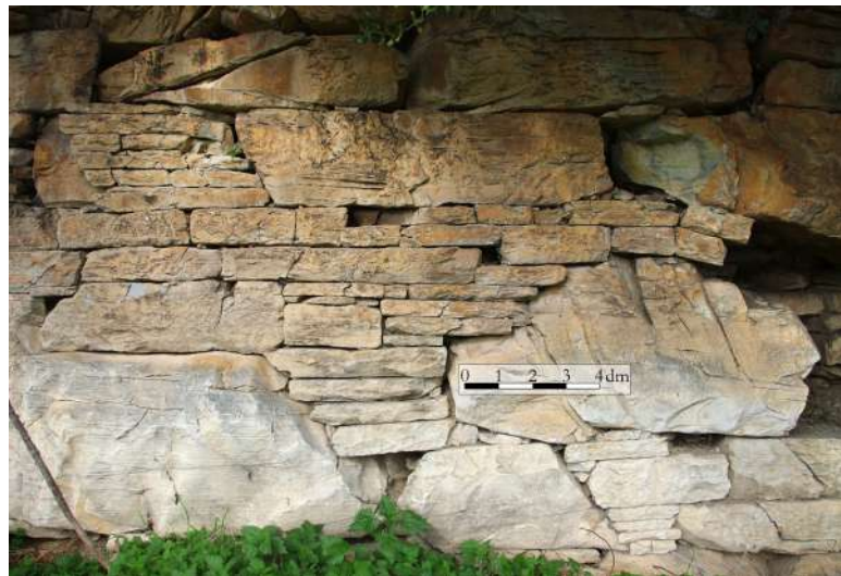
Befästningsmur på Pergamos södra sida, c. 500 f.Kr. i så kallad stack-work teknik.
